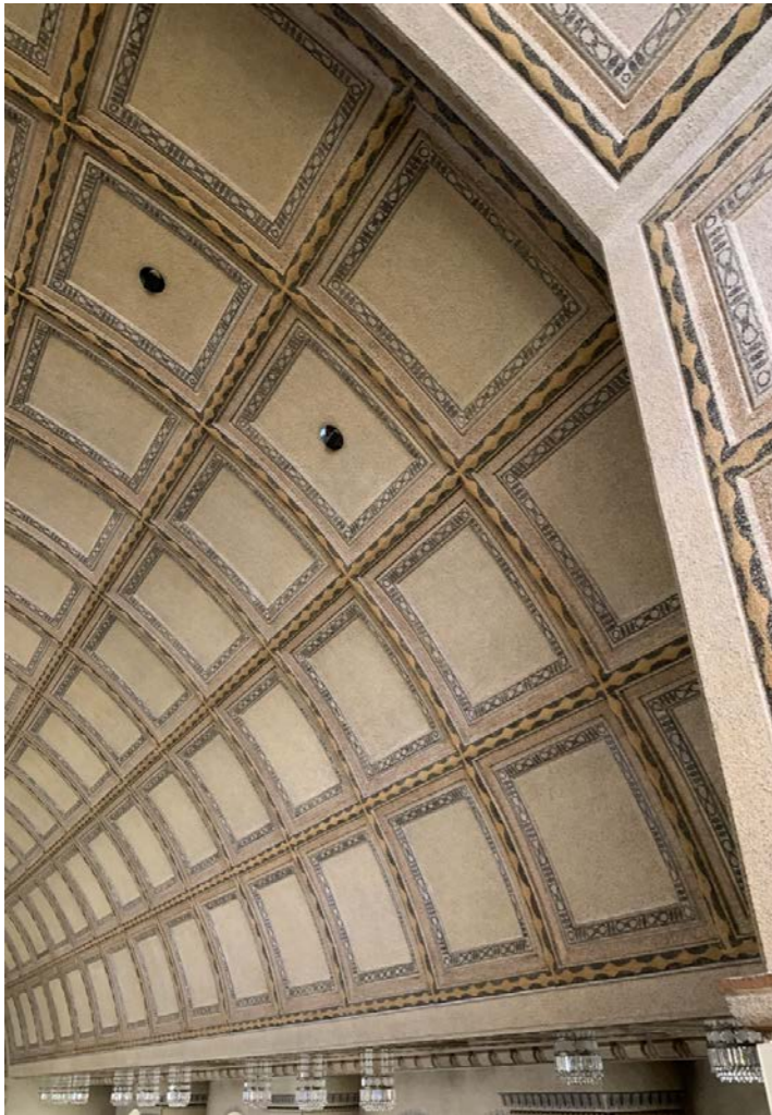
13.01 / 13.02 Die bestehenden Deckenöffnungen werden genutzt für versenkte Richtstrahler. Bei der Empore über dem Chor, verbleiben die Pendelleuchten, Ersatz in LED.
